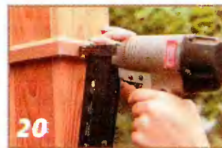
20 Декоративные раскладки удобно крепить скобозавивным пистолетом.
