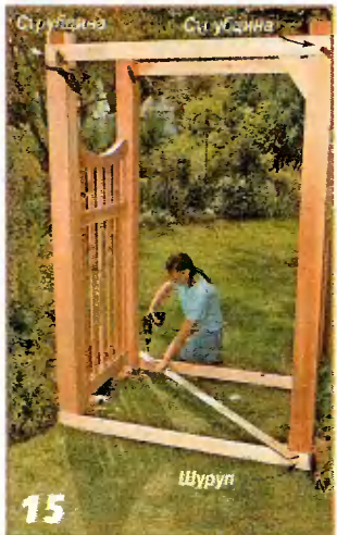
15 Временную жёсткость конструкции придаёт диагональная связь.
