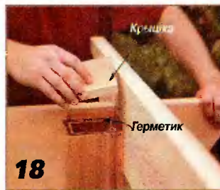
18 Крышку столба крепят шурупами на герметике.
